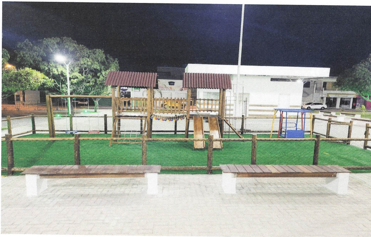
FOTO 32 - FORNECIMENTO E INSTALAÇÃO DE GRAMA SINTÉTICA 42MM, ALTA DURABILIDADE, COR VERDE, PROTEÇÃO RAIOS UV E LUZ SOLAR, INCLUSO COLA, TYPE, AREIA TRATADA, BORRACHA E MÃO DE OBRA ESPECIALIZADA
