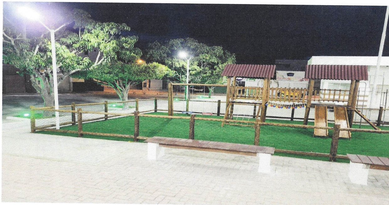
FOTO 32 - FORNECIMENTO E INSTALAÇÃO DE GRAMA SINTÉTICA 42MM, ALTA DURABILIDADE, COR VERDE, PROTEÇÃO RAIOS UV E LUZ SOLAR, INCLUSO COLA, TYPE, AREIA TRATADA, BORRACHA E MÃO DE OBRA ESPECIALIZADA
